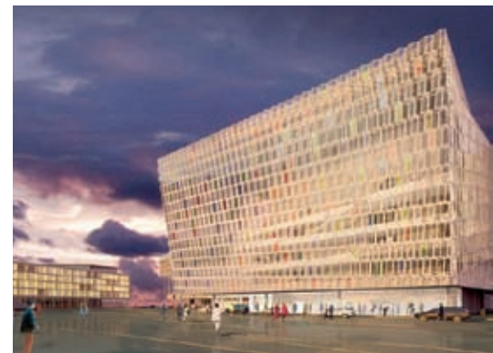
Ein dänisches Architekturbüro hat das Konzert- und Konferenzzentrum für Reykjavík entworfen, das sich derzeit in der Bauphase befindet.
